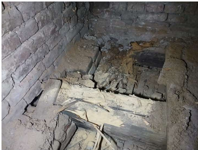
Slika 9. Trulež oslonačke zone tavanjače u ispitnom traktu br. 7, kritična tačka 4
