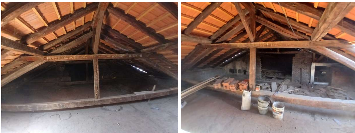
Slika 4. Drvena krovna konstrukcija: jednostruka krovna vešaljka
