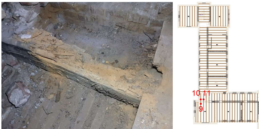
Slika 15. Trulež oslonačke zone tavanjače u ispitnom traktu br. 8, kritična tačka 10
