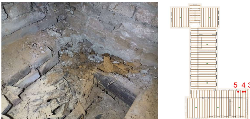
Slika 8. Trulež oslonačke zone tavanjače u ispitnom traktu br. 7, kritična tačka 3
