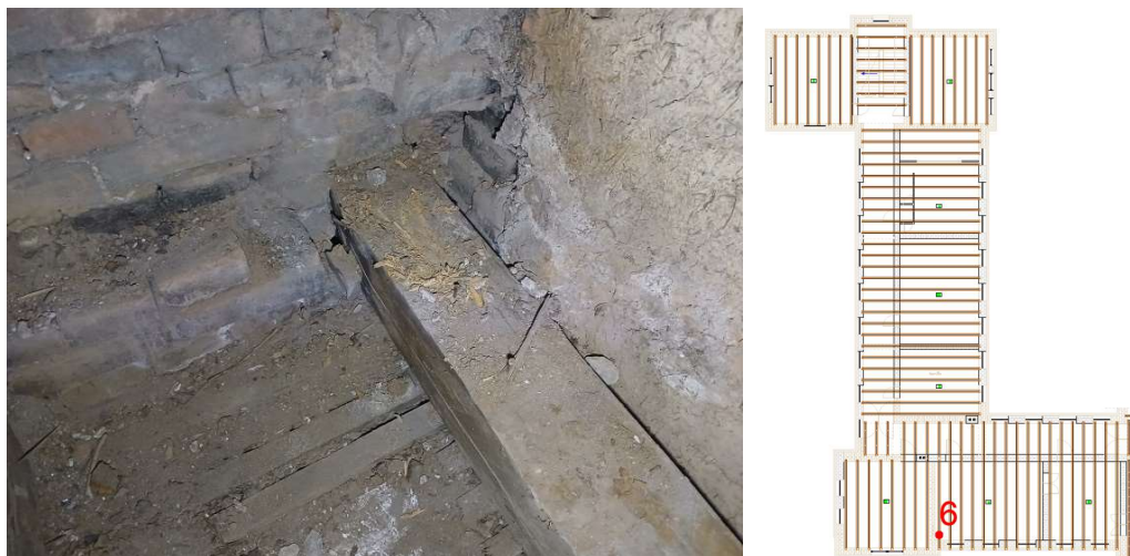
Slika 11. Trulež oslonačke zone tavanjače u ispitnom traktu br. 7, kritična tačka 6
