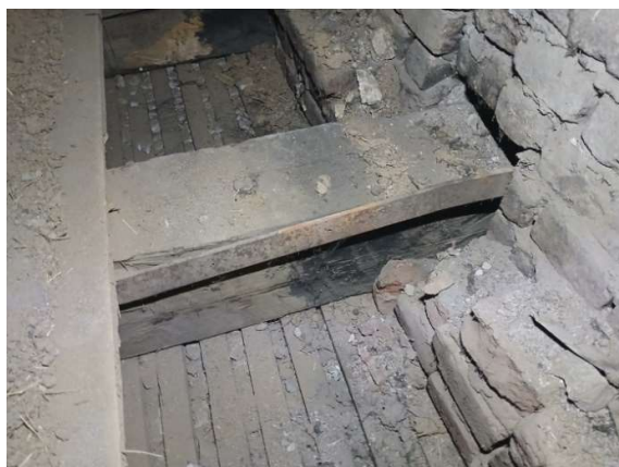
Slika 19. Veza metalnih klanfi i drvenih tavanjača (sala 27)
