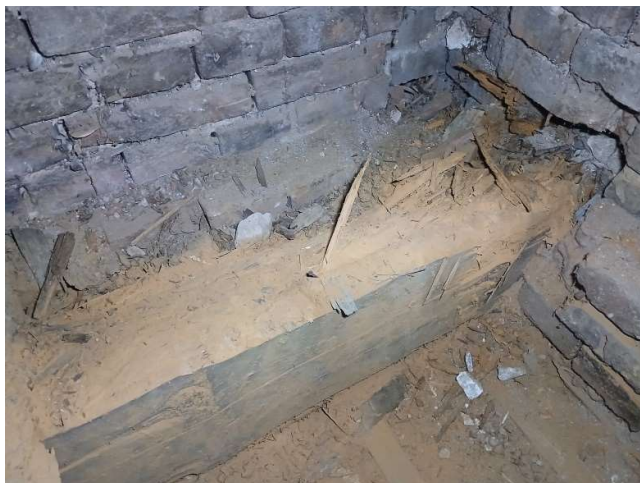
Slika 17. Trulež oslonačke zone tavanjače u ispitnom traktu br. 1, kritična tačka 12
