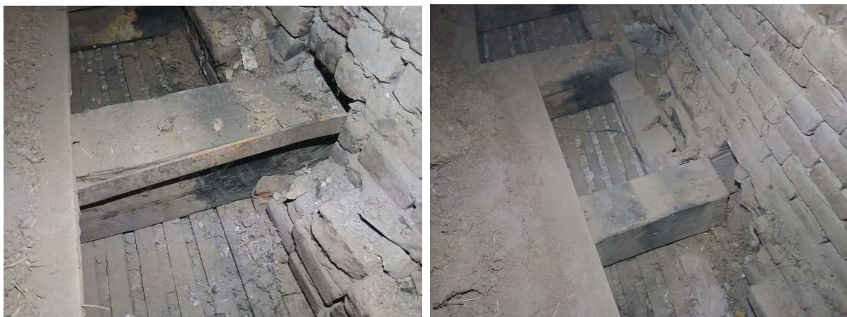
Slika 6. Izgled tavanice i plafonske konstrukcije gledano sa gornje strane
