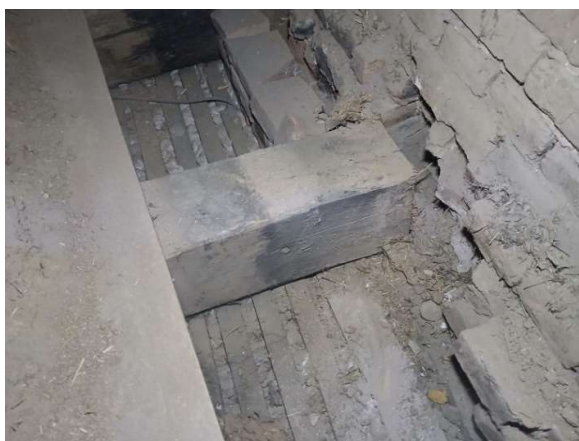
Slika 18. Detalj oslanjanja tavanjača preko drvenog jastuka b/d=10/10cm
