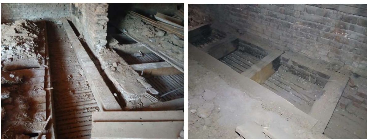
Slika 3. Drvena međuspratna tavanica sprata - karatavan
