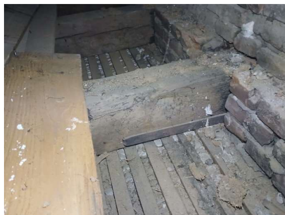
Slika 19. Veza metalnih klanfi i drvenih tavanjača (sala 27)
