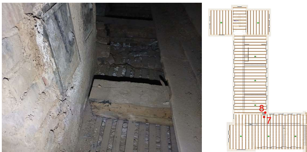
Slika 13. Izostanak vekslanja prekinute tavanjače na mestu oslanjanja na dimnjak u osi 4
