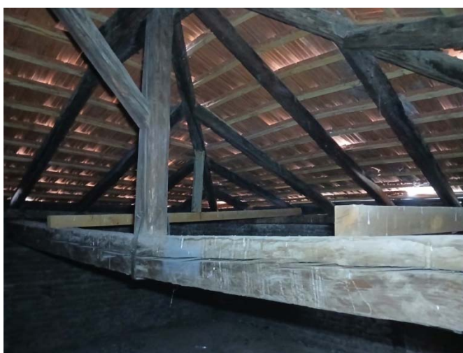
Slika 69. Sekundarni gredni sistem za podupiranje „grebenjača“ (levo), metalna veza primerena vezi zatega-stub kod vešaljke (desno)
