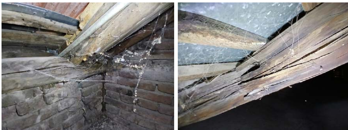
Slika 81. Satrulela nadzidnjača (levo), satruleo spoj uvalnice i roga (desno)
