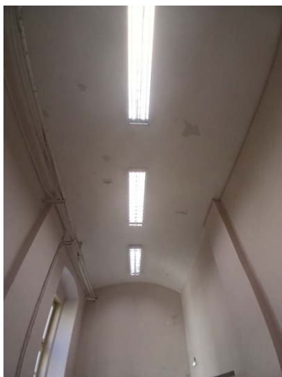
Slika 30. Zasvedena tavanica prizemlja na delu komunikacionih traktova (levo), tavanica ispod centralnog stepeništa (desno)
