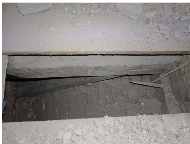
Slika 44. Pogled na unutrašnju stranu profilacije plafona iznad centralnog hola: kaverna br. 11 (levo), kaverna br. 12 (desno)
