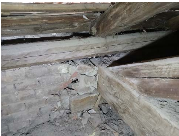
Slika 63. Tipska oštećenja drvenih jastuka krovne „vešaljke“
