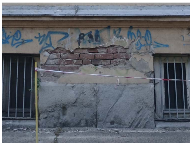
Slika 51. Dejstvo vlage u soklenim zidovima (levo), oštećenja maltera usled dejstva vlage i mraza (desno)
