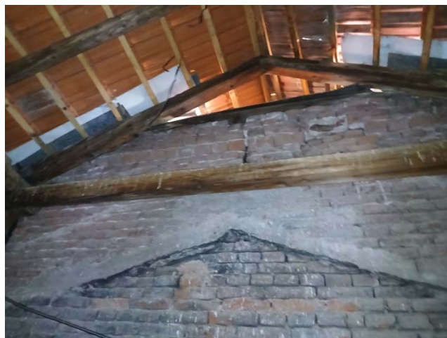
Slika 2. Pogled iz tavanskog prostora osnovnog objekta na drvenu krovnu konstrukciju i zidove atike (razlike u izvođenju donjeg i gornjeg dela atike ukazuje na korekcije nastale tokom izvođenja radova)
