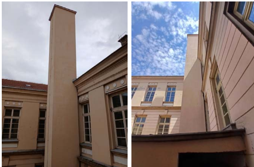
Slika 107. Zidani dimnjak kotlarnice trajno van upotrebe
