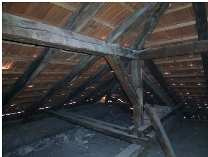
Slika 75. Pogled na drvenu krovnu konstrukciju iznad centralnog hola, krovni vezač TIP 3 u osi 5
