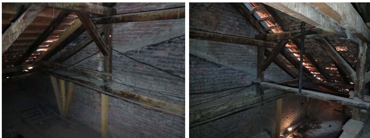
Slika 79. Krovni vezač TIP 4
