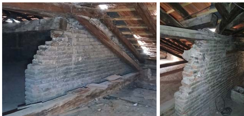
Slika 85. Dekompozicija sloga krovnih nadzidaka i oslonačkih zidova
