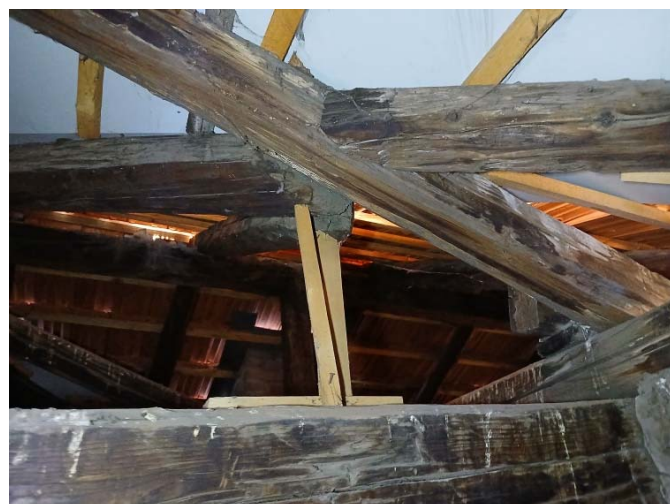
Slika 71. Neadekvatno oslanjanje i izostanak jasnog sleda opterećenja (levo), prekinut rog u sastavu glavnog vezača TIP 2 (desno)
