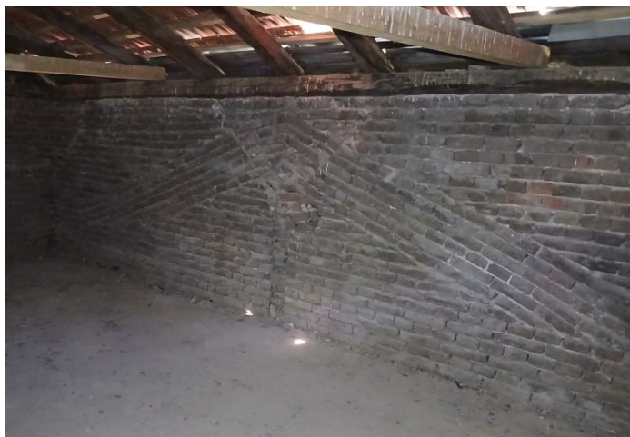
Slika 2. Pogled iz tavanskog prostora osnovnog objekta na drvenu krovnu konstrukciju i zidove atike (razlike u izvođenju donjeg i gornjeg dela atike ukazuje na korekcije nastale tokom izvođenja radova)
