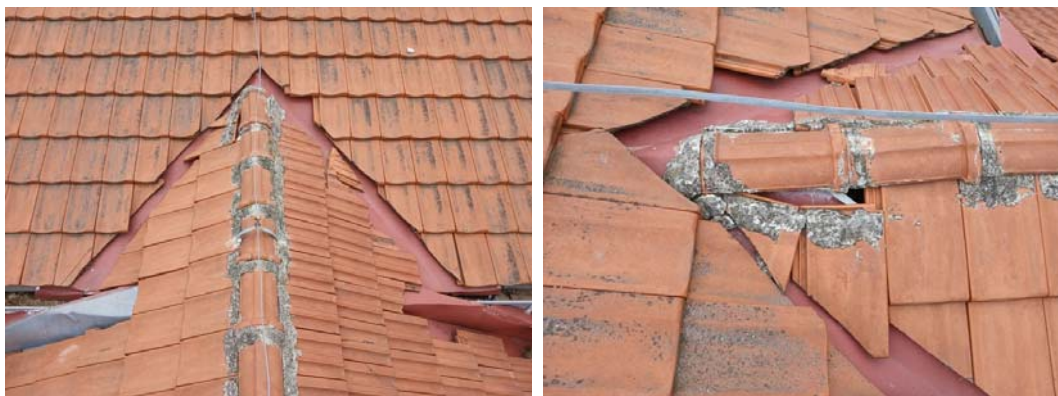
Slika 92. Rasturen pokrov crepom u slemenu u osi F
