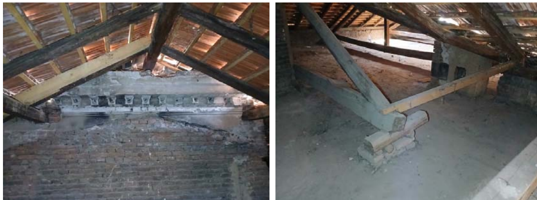
Slika 86. Zamena pojedinačnih elemenata krovne konstrukcije
