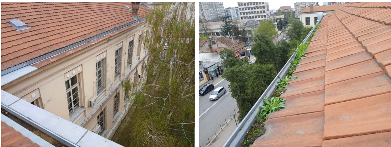
Slika 100. Dužina olučne horizontale na istočnom krilu (levo), oluk na južnoj fasadi iznad centralnog ulaza (desno)
