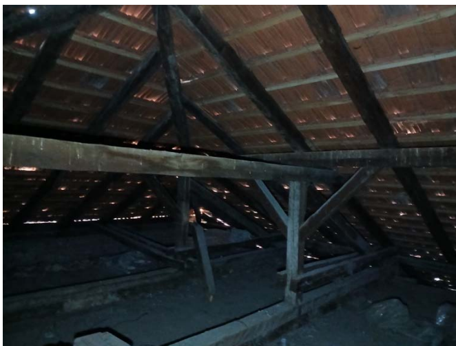
Slika 75. Pogled na drvenu krovnu konstrukciju iznad centralnog hola, krovni vezač TIP 3 u osi 5
