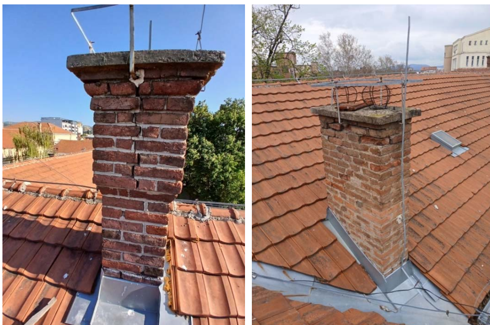
Slika 90. Ispucali dimnjaci
