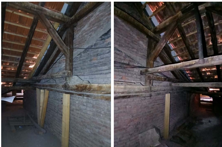
Slika 78. Krovni vezač TIP 4
