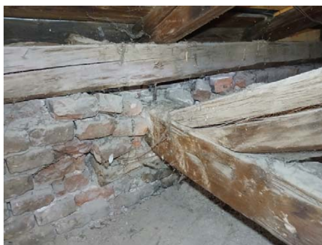
Slika 62. Tipska oštećenja drvenih jastuka krovne „vešaljke“
