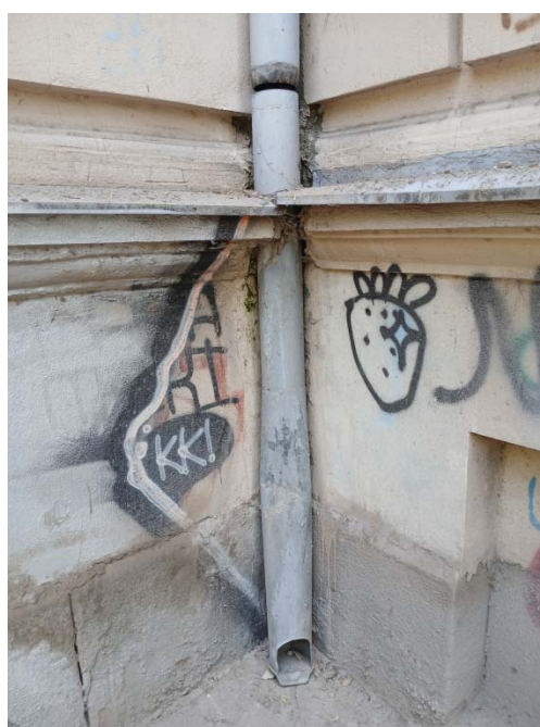
Slika 52. Izlivanje olučnih vertikla neposredno uz objekat
