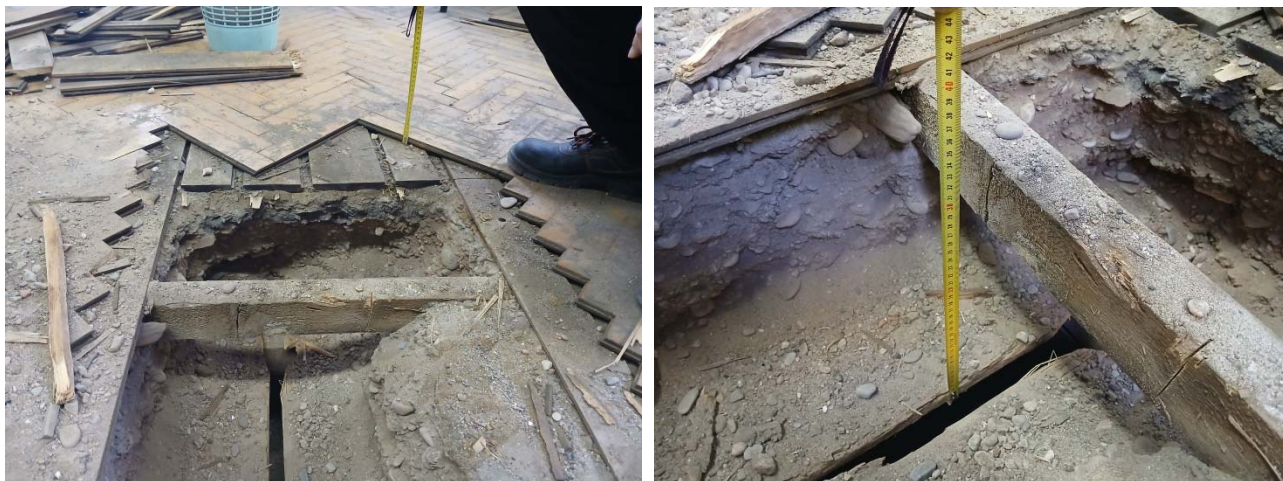
Slika 25. Otvaranje kaverne broj 1 u podu sale br. 31 (levo), debljina šljunčanog nasipa (desno)
