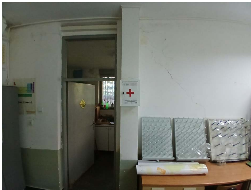
Slika 109. Dijagonalne pukotine na poprečnim i podužnim zidovima aneksa u laboratoriji za hemiju
