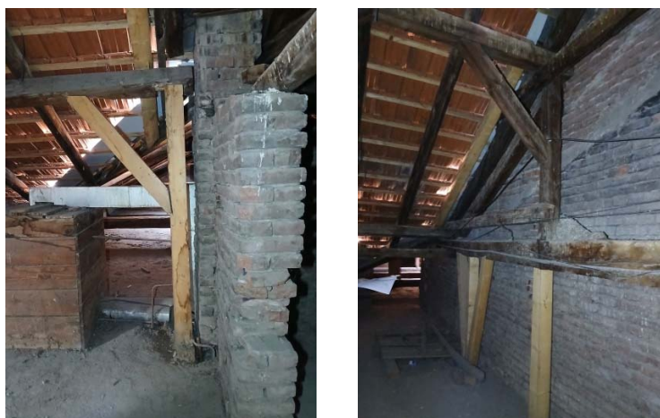
Slika 14. Naknadna sanacija drvene krovne konstrukcije kod ose I (levo) i kod ose 3 (desno)
