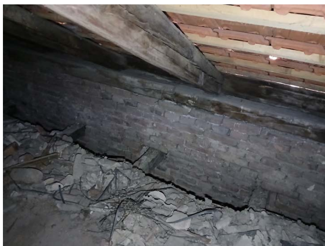
Slika 43. Sekundarne tavanjače u kaverni br. 12 (levo), oštećenja zida u osi – 6 na mestu oslanjanja tavanjača kaverna br. 12 (desno)
