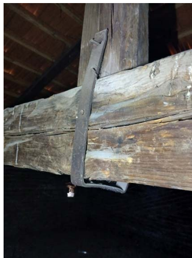
Slika 69. Sekundarni gredni sistem za podupiranje „grebenjača“ (levo), metalna veza primerena vezi zatega-stub kod vešaljke (desno)
