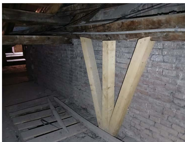
Slika 41. Satrulela tavanjača u kaverni br. 8 (levo), pogled na trenutno pokrivenu kavernu br. 9 (desno)
