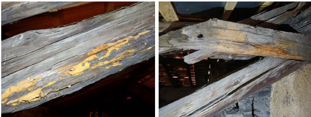
Slika 82. Satruleo rog usled dejstva crvotočine (levo), satrulela klešta (desno)
