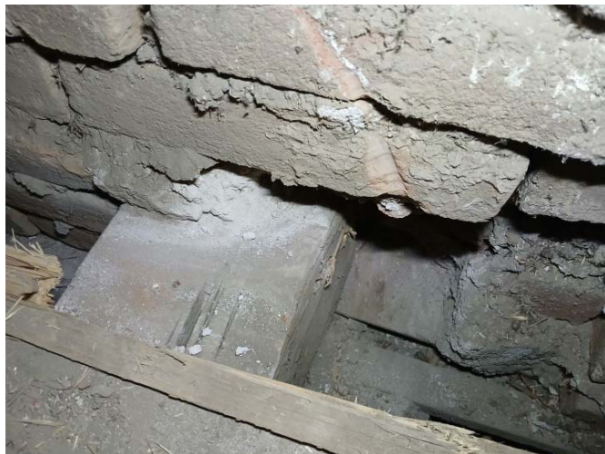
Slika 42. Čelični nosač između stubova u osi - 4 kaverna br. 10 (levo), šut iznad profilacije plafona uz zid u osi - 6 kaverna br. 12 (desno)
