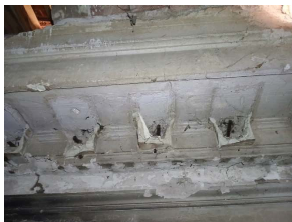
Slika 53. Malterska plastika venca u osi E (levo), oštećena malterska plastika venca na sada unutrašnjem delu atike u osi E (desno)
