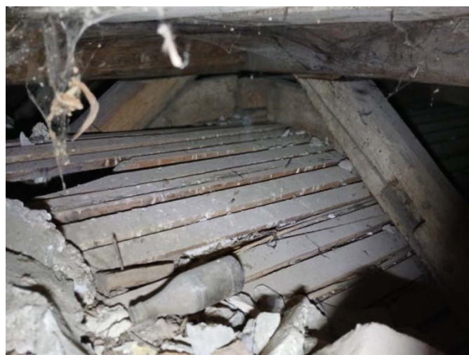
Slika 44. Pogled na unutrašnju stranu profilacije plafona iznad centralnog hola: kaverna br. 11 (levo), kaverna br. 12 (desno)
