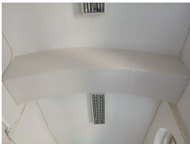
Slika 31. Karakteristične prsline na lukovima iznad komunikacionog trakta prizemlja
