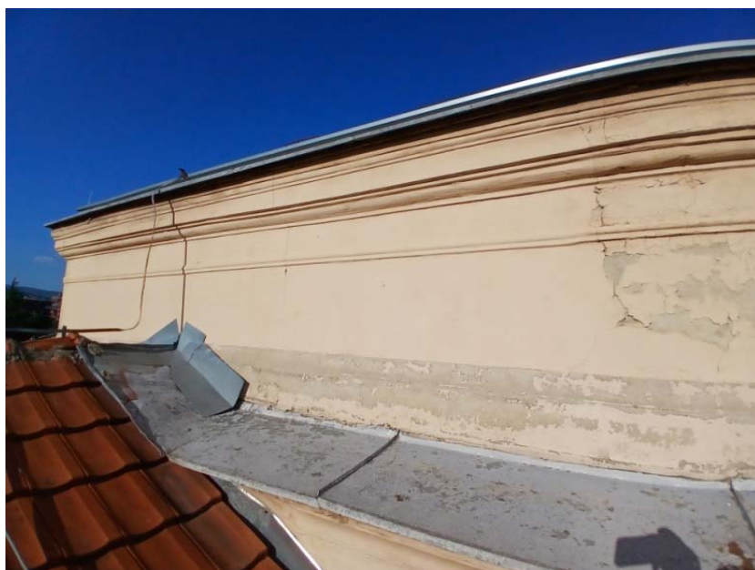
Slika 48. Pukotina u zidu atike u osi G, simetrična pukotina u zidu u osi E
