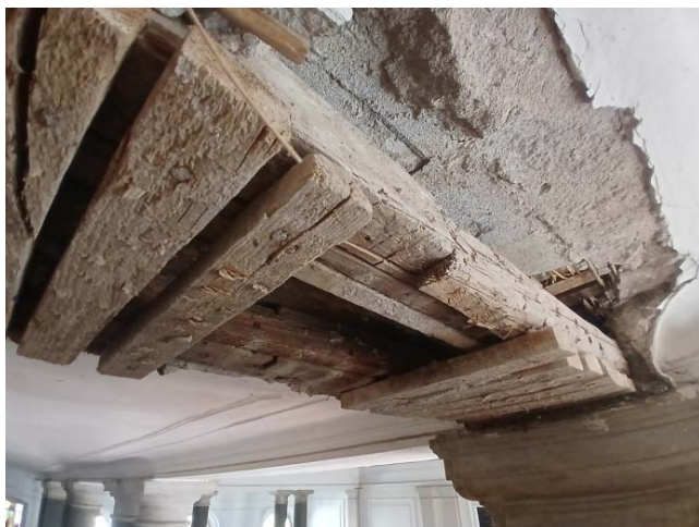
Slika 36. Detalj oštećenja profilacije iznad komunikacionog trakta centralnog hola na spratu
