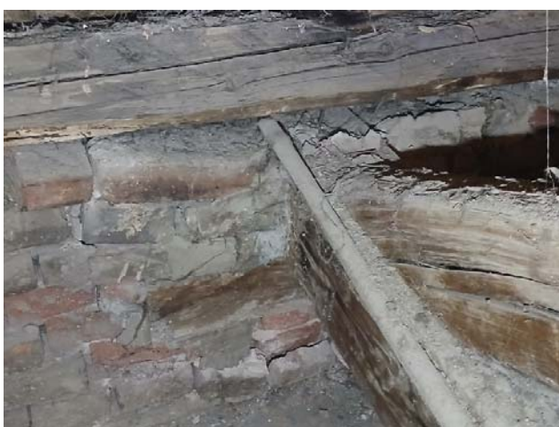
Slika 62. Tipska oštećenja drvenih jastuka krovne „vešaljke“
