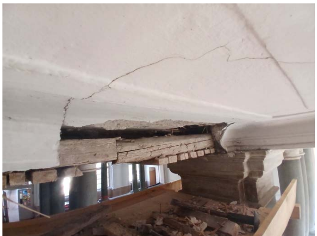
Slika 36. Detalj oštećenja profilacije iznad komunikacionog trakta centralnog hola na spratu
