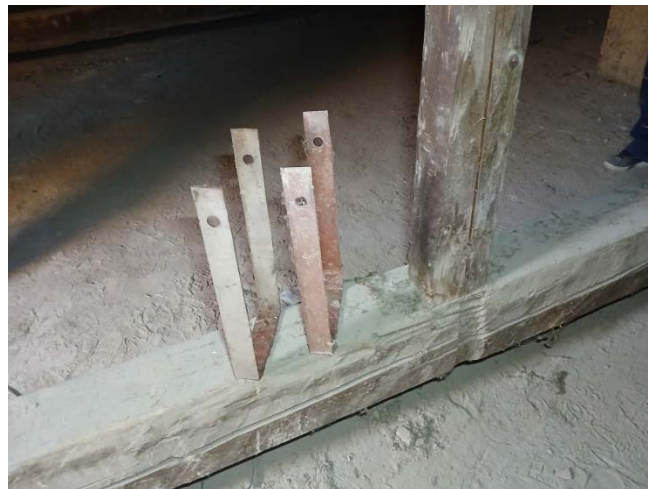
Slika 65. Izostanak metalne vezice na stubu vešaljke (levo), neugrađene metalne vezice (desno)
