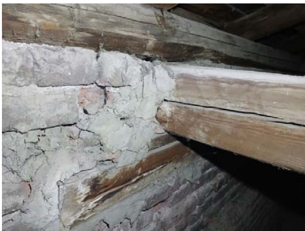
Slika 61. Tipska oštećenja drvenih jastuka krovne „vešaljke“ i zarotirane venčanice
