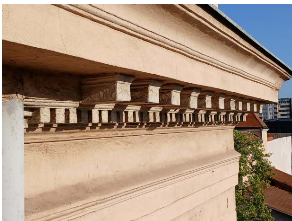
Slika 53. Malterska plastika venca u osi E (levo), oštećena malterska plastika venca na sada unutrašnjem delu atike u osi E (desno)
