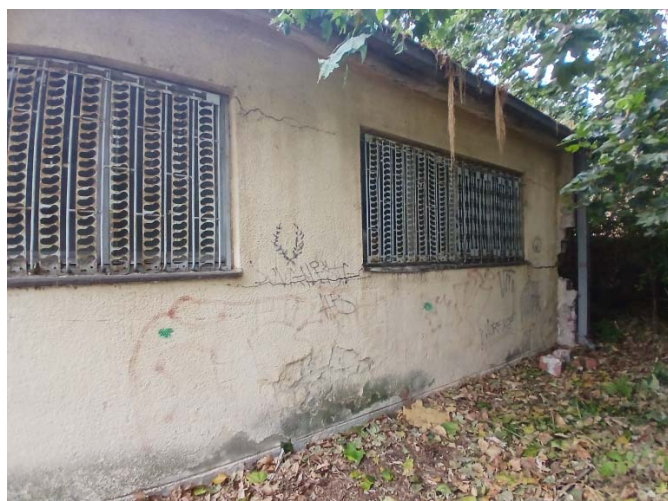
Slika 110. Pukotine na fasadnom zidu aneksa (levo), potpuna dezintegracija zida u uglu objekta (desno)
