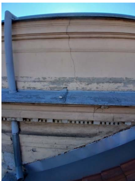
Slika 48. Pukotina u zidu atike u osi G, simetrična pukotina u zidu u osi E
