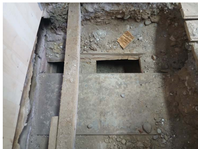
Slika 26. Otvaranje kaverne broj 2 u podu sale br. 31 (levo), čelični rofil u sredini raspona (desno)
