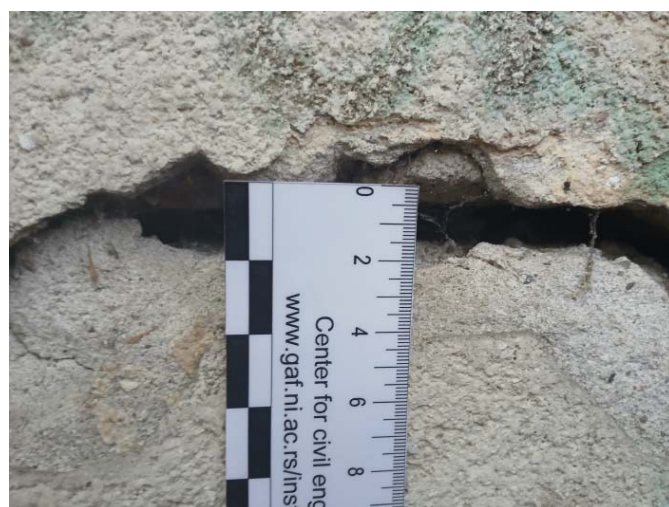
Slika 111. Prsline u zidovima aneksa (levo), pukotine na fasadnim zidovima širine do 22 mm (desno)
