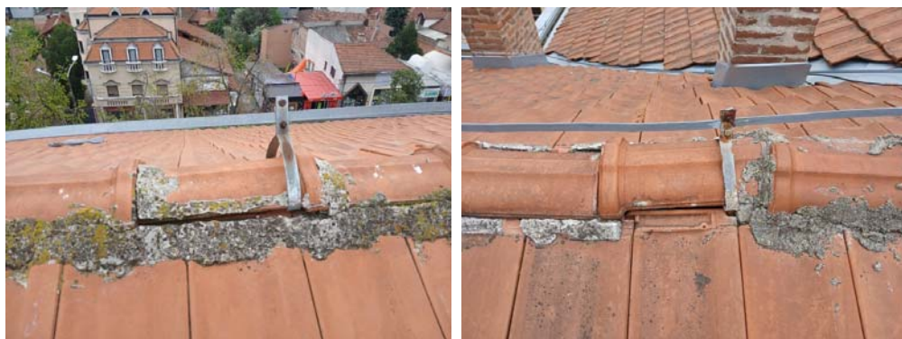
Slika 95. Uticaj gromobranskih držača na poklopce slemena
