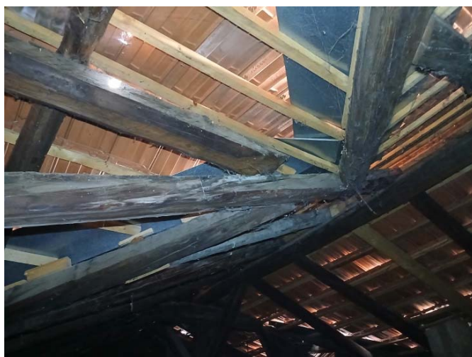
Slika 71. Neadekvatno oslanjanje i izostanak jasnog sleda opterećenja (levo), prekinut rog u sastavu glavnog vezača TIP 2 (desno)
