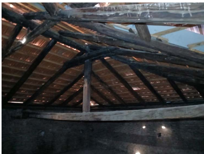
Slika 68. Vezač TIP 2 delimično zahvaćen požarom (levo), prekomerne deformacije glavnog grednog nosača (desno)
