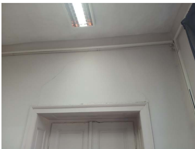
Slika 47. Sistem pukotina u zidu u osi E na prvom spratu (levo), propagacija istih prslina kroz kalkansku zid tavana u osi E (desno)
