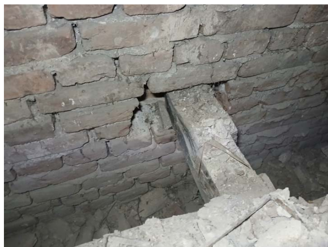
Slika 43. Sekundarne tavanjače u kaverni br. 12 (levo), oštećenja zida u osi – 6 na mestu oslanjanja tavanjača kaverna br. 12 (desno)
