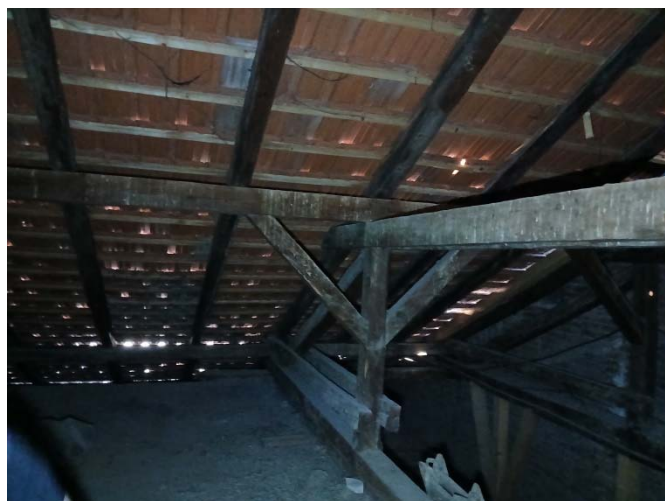
Slika 76. Pogled na drvenu krovnu konstrukciju iznad centralnog hola, krovni vezač TIP 3 u osi 4
