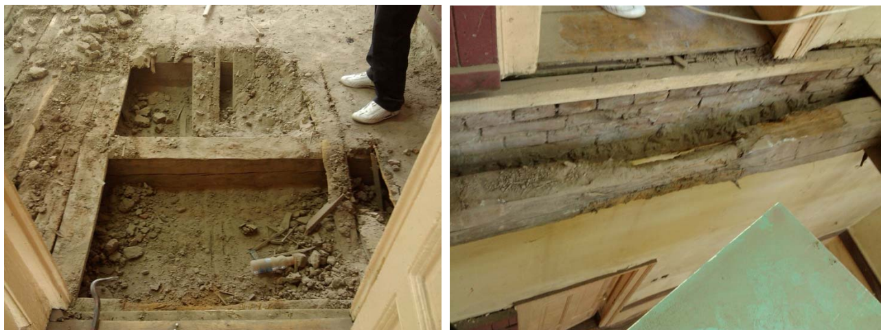
Slika 29. Arhivske fotografije prilikom sanacije tavanice iznad sale br. 21 (9. septembar 2013.) (Izvor: Zavod za zaštitu spomenika kulture Niš)
