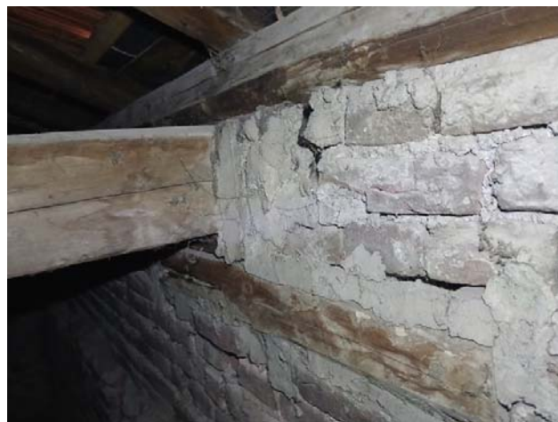
Slika 61. Tipska oštećenja drvenih jastuka krovne „vešaljke“ i zarotirane venčanice
