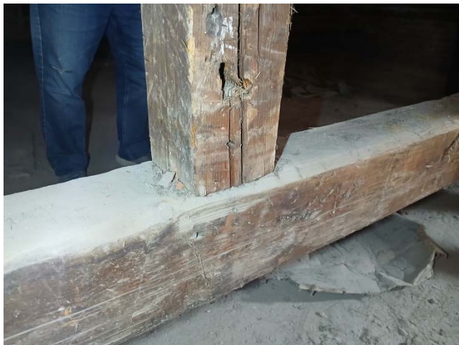
Slika 65. Izostanak metalne vezice na stubu vešaljke (levo), neugrađene metalne vezice (desno)
