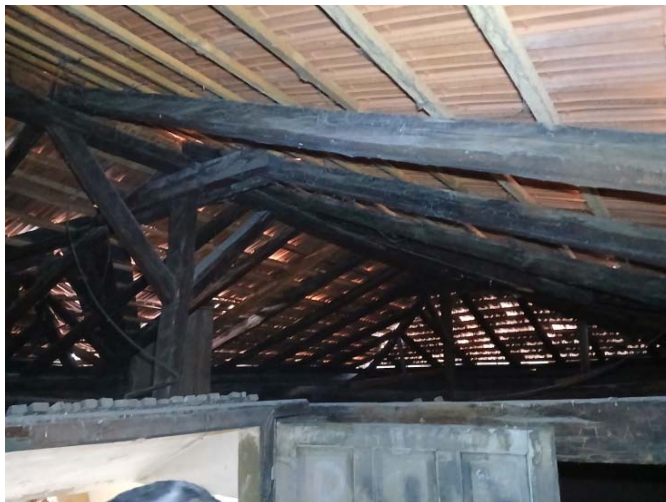
Slika 70. Pogled na središnji vezač TIP 2 u osi - I (levo), posledice lokalnog požara u krovno konstrukciji na delu između osa J-I / 9-10 (desno)
