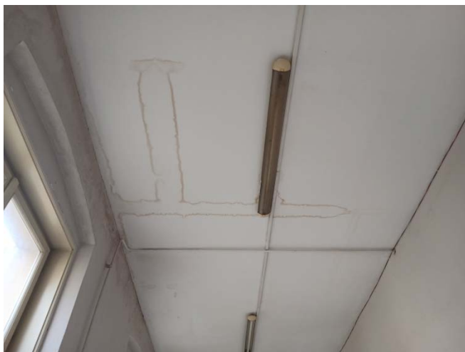
Slika 34. Tragovi procurivanja vode sa krova u komunikacionim traktovima i učionici br. 31
