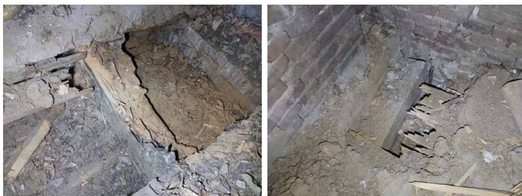
Slika 39. Trule tavanjače u kaverni br. 4 (levo), nedovoljna dubina oslanjanja tavanjače na zidani zid kaverna br. 5(desno)
