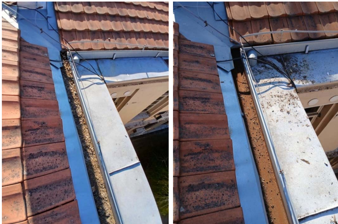
Slika 103. Olučna horizontala u osi 4, levo krilo objekta pre i posle čišćenja od strane radnika GAF-a
