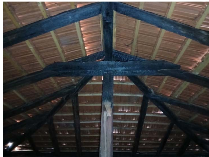
Slika 70. Pogled na središnji vezač TIP 2 u osi - I (levo), posledice lokalnog požara u krovno konstrukciji na delu između osa J-I / 9-10 (desno)
