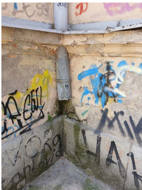
Slika 52. Izlivanje olučnih vertikla neposredno uz objekat
