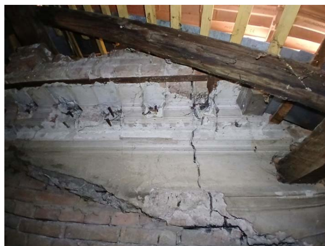
Slika 47. Sistem pukotina u zidu u osi E na prvom spratu (levo), propagacija istih prslina kroz kalkansku zid tavana u osi E (desno)
