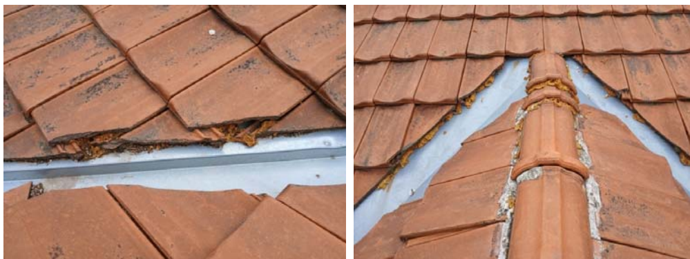
Slika 94. Loše ukrojen crep na mestu uvale (levo), vezivanje crepa i žljebnjaka pur-penom (desno)
