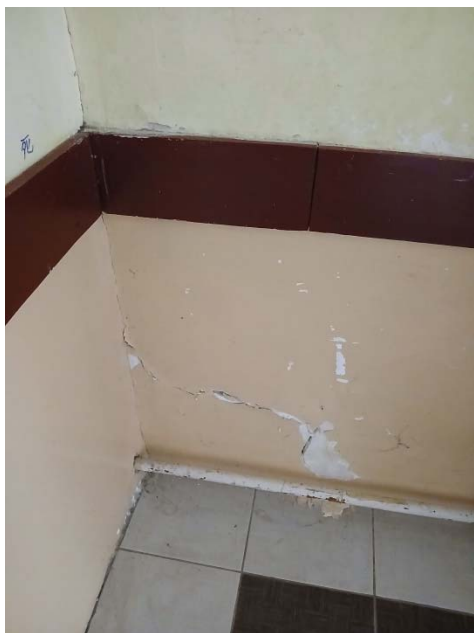
Slika 109. Dijagonalne pukotine na poprečnim i podužnim zidovima aneksa u laboratoriji za hemiju
