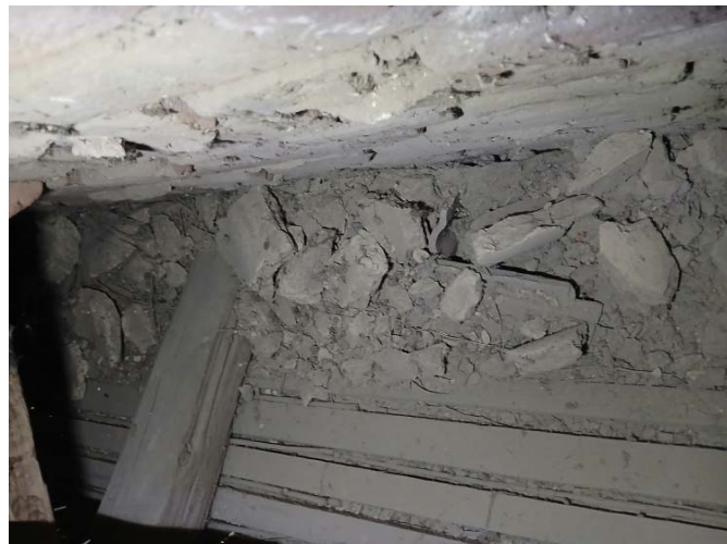
Slika 42. Čelični nosač između stubova u osi - 4 kaverna br. 10 (levo), šut iznad profilacije plafona uz zid u osi - 6 kaverna br. 12 (desno)
