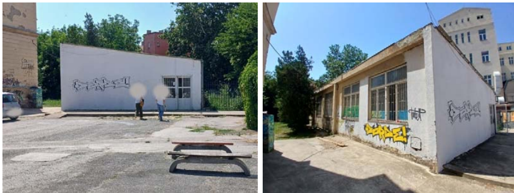
Slika 21. Pomoćni objekat za obrazovanje: istočna fasada sa ulazom (levo), južna fasada desno (desno)
