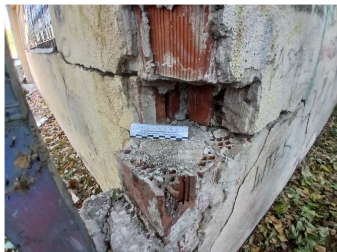
Slika 110. Pukotine na fasadnom zidu aneksa (levo), potpuna dezintegracija zida u uglu objekta (desno)
