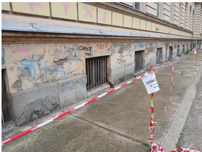
Slika 51. Dejstvo vlage u soklenim zidovima (levo), oštećenja maltera usled dejstva vlage i mraza (desno)
