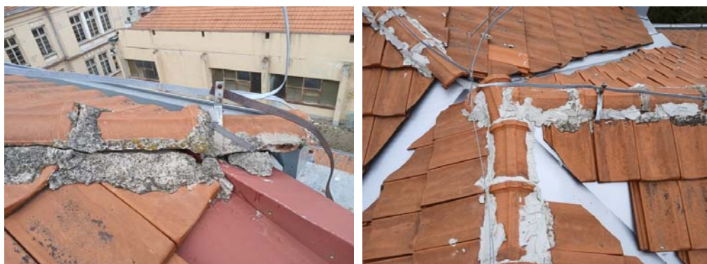
Slika 96. Uticaj gromobranskih držača na poklopce grebena i slemena
