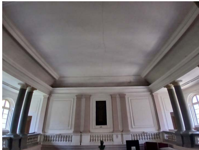
Slika 35. Centralni hol (levo), pogled na plafonsku konstrukciju i pukotina po sredini raspona (desno)
