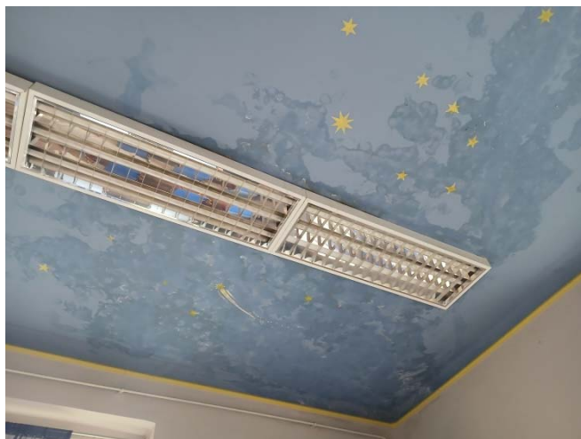
Slika 34. Tragovi procurivanja vode sa krova u komunikacionim traktovima i učionici br. 31
