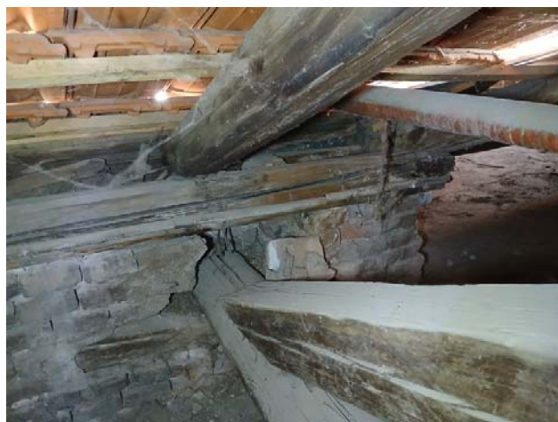
Slika 63. Tipska oštećenja drvenih jastuka krovne „vešaljke“
