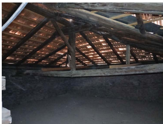
Slika 68. Vezač TIP 2 delimično zahvaćen požarom (levo), prekomerne deformacije glavnog grednog nosača (desno)
