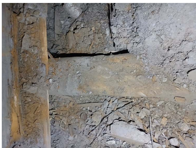
Slika 41. Satrulela tavanjača u kaverni br. 8 (levo), pogled na trenutno pokrivenu kavernu br. 9 (desno)
