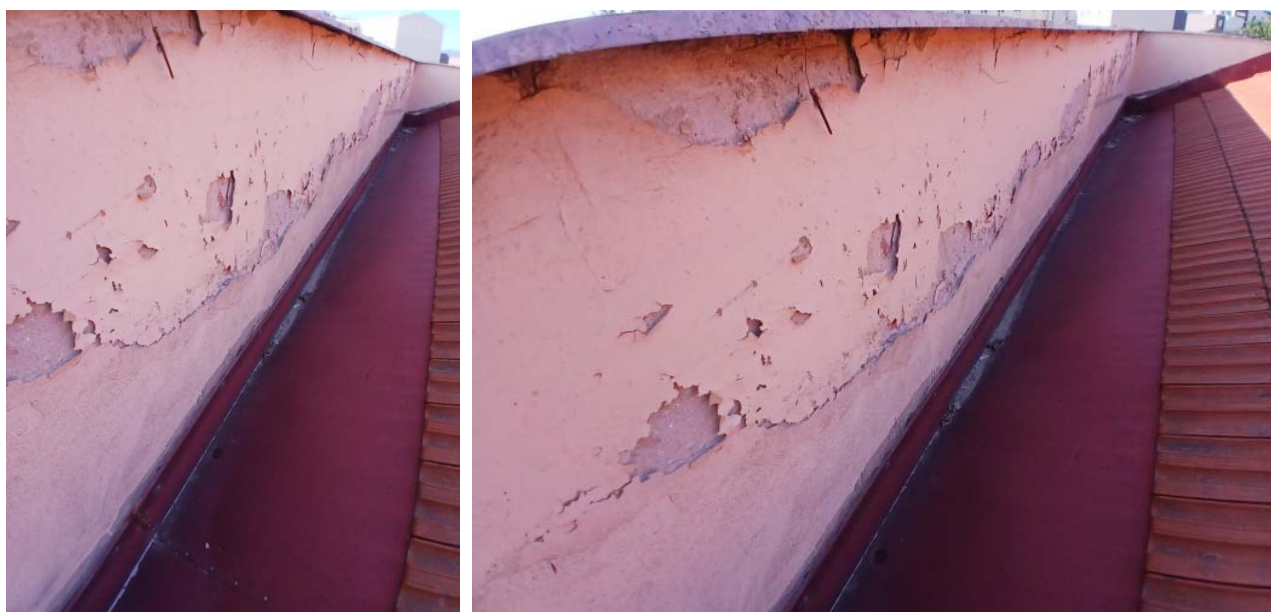
Slika 102. Neprimereno nizak limeni opšiv na mestu iza atike u osi E
