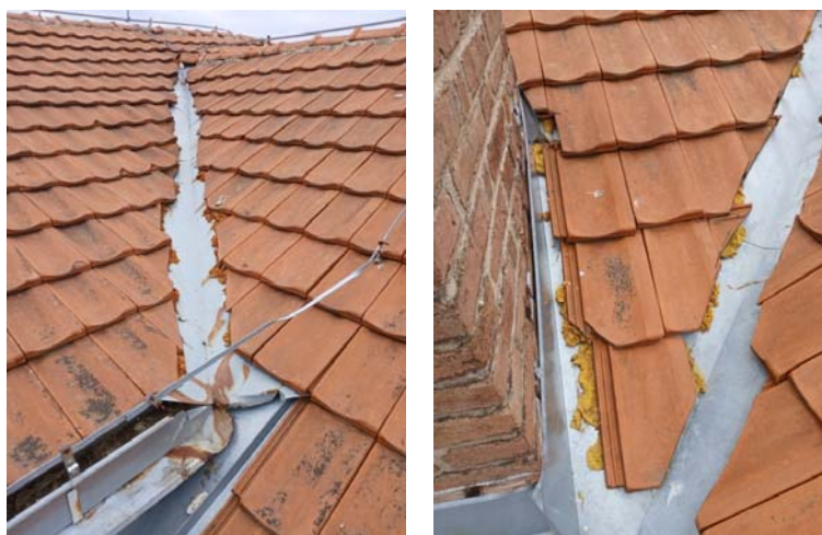
Slika 93. Loše ukrojen crep na mestu uvale (levo), vezivanje crepa pur-penom (desno)
