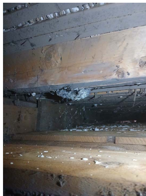
Slika 15. Pogled na međuprostor tavanice iznad svečane sale, stanje okagače i tavanjača
