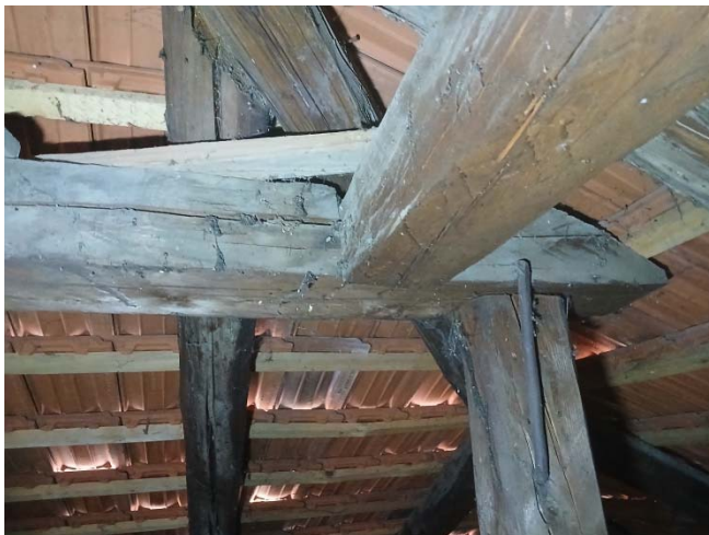
Slika 18. Loše oblikovanje detalja čvornih veza krova iznad svečane sale
