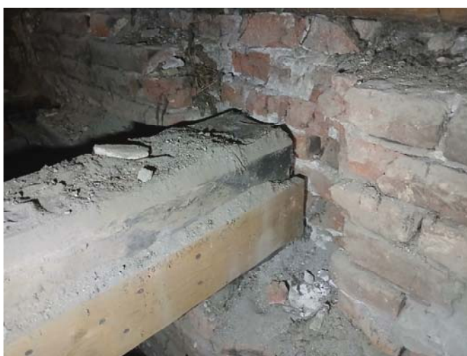
Slika 14. Loše izveden oslonac primarne tavanjače sa nedovoljnom dubinom naleganja (levo), oštećen i u dva navrata saniran oslonac primarne tavanjače iznad svečane sale (desno)
