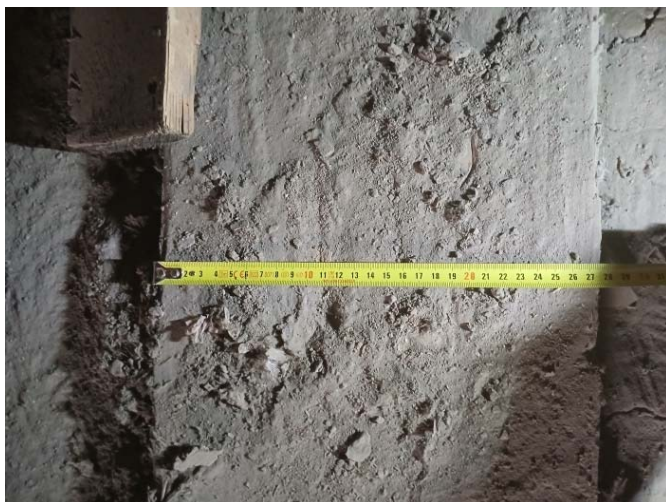
Slika 13. Glavni nosači tavanice iznad svečane sale b/d=28/30\text{cm}
