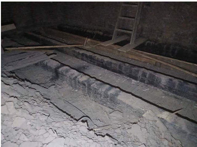
Slika 3. Nagorele tavanjače iznad sale br. 42
