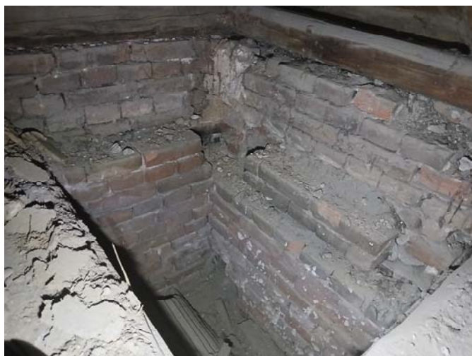
Slika 11. Tragovi oslonačkih „gnezda“ tavanjača izvorne konstrukcije tavanice iznad svečane sale
