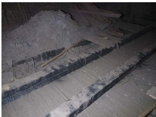
Slika 3. Nagorele tavanjače iznad sale br. 42
