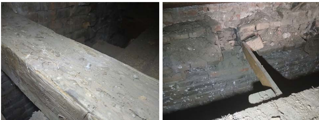
Slika 16. Lokalna pojava crvotočine u površinskom sloju glavnog nosača tavanice (levo), kratka sekundarna tavanjača produžena colovom daskom (desno)
