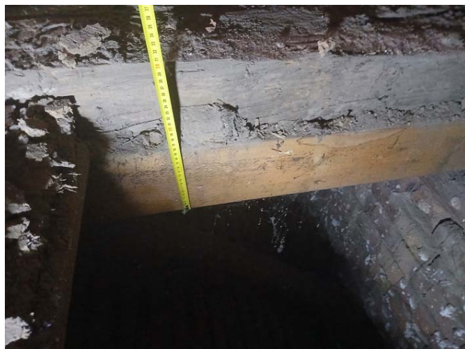
Slika 13. Glavni nosači tavanice iznad svečane sale b/d=28/30\text{cm}
