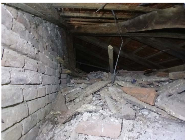
Slika 19. Stanje krovne konstrukcije (levo) i tavanjače (desno) iznad dograđenih sanitarnih čvorova u osi 6
