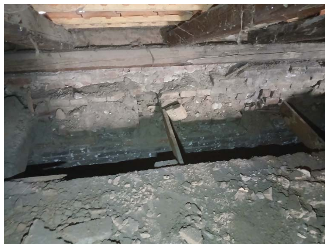
Slika 11. Tragovi oslonačkih „gnezda“ tavanjača izvorne konstrukcije tavanice iznad svečane sale
