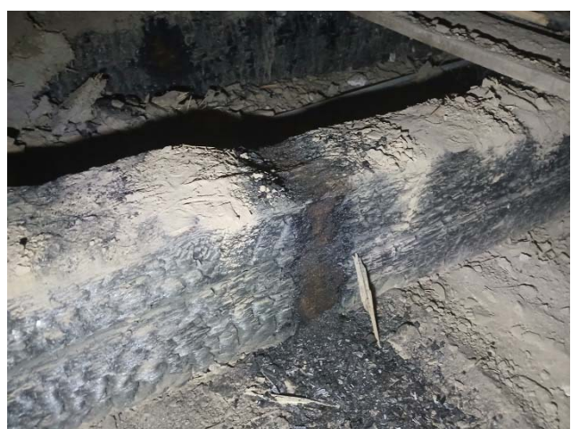
Slika 4. Nagorele grede - redukcija poprečnog preseka tavanjača iznad sale br. 42
