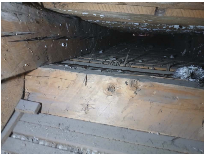
Slika 15. Pogled na međuprostor tavanice iznad svečane sale, stanje okagače i tavanjača
