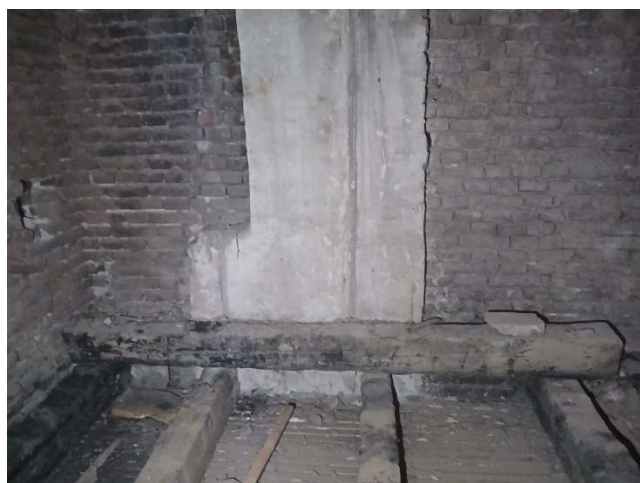
Slika 2. Nagorela tavanjača i zamenjena skraćenica iznad sale br. 42 (levo), greda menjačica i reparirani dimnjak u zidu u osi 9 (desno)
