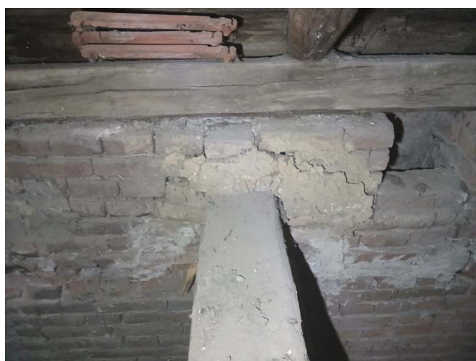
Slika 14. Loše izveden oslonac primarne tavanjače sa nedovoljnom dubinom naleganja (levo), oštećen i u dva navrata saniran oslonac primarne tavanjače iznad svečane sale (desno)
