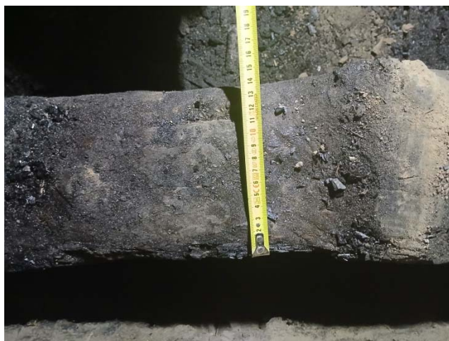
Slika 4. Nagorele grede - redukcija poprečnog preseka tavanjača iznad sale br. 42
