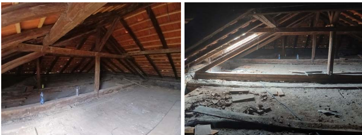
Slika 17. Opšte stanje krovne konstrukcije iznad svečane sale
