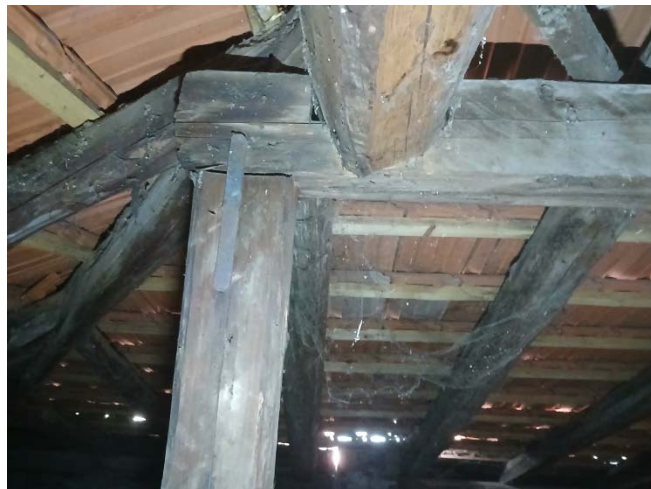
Slika 18. Loše oblikovanje detalja čvornih veza krova iznad svečane sale
