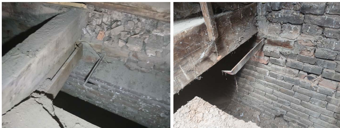
Slika 10. Izostanak klanfi na delu tavanice iznad svečane sale
