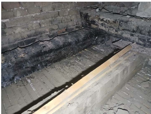
Slika 2. Nagorela tavanjača i zamenjena skraćenica iznad sale br. 42 (levo), greda menjačica i reparirani dimnjak u zidu u osi 9 (desno)
