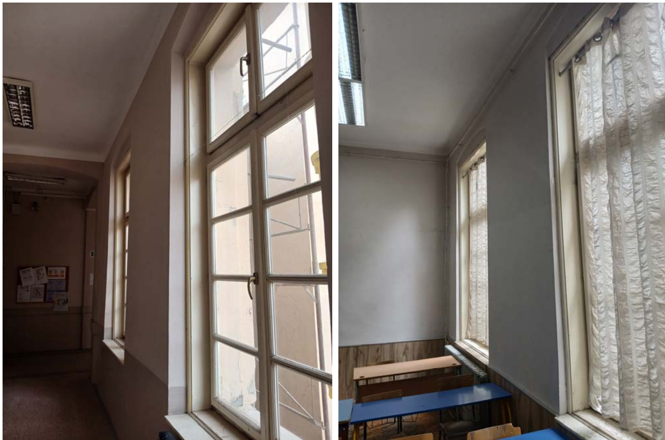
Slika 9. Imperfekcija zidova usled naginjanja ka „spolja“ vidljiva na mestima nejednake širine špaletni prozora istočnog krila (levo), zapadnog krila (desno)
