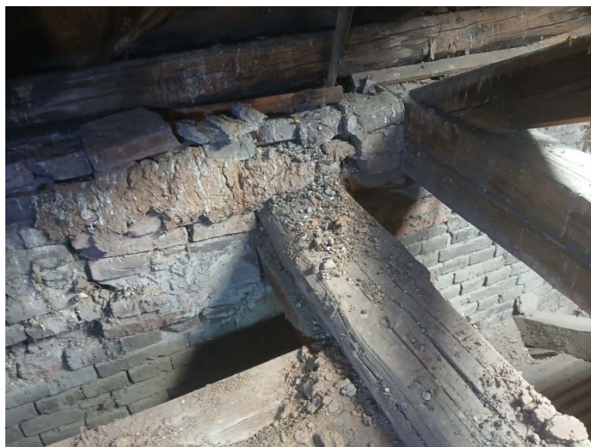
Slika 12. Dezintegrirani oslonci glavnih nosača tavanice i krovnog vezača iznad svečane sale
